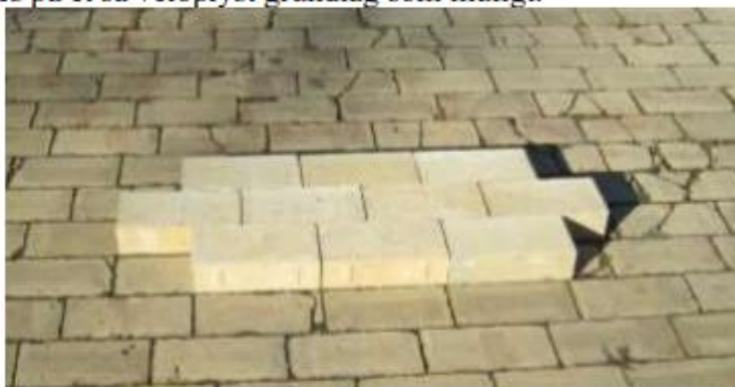
Figur 1- Betonklinke fra IBF ovenpå eksisterende belægning
