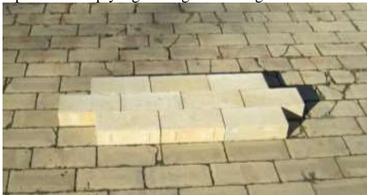
Figur 1- Betonklinke fra IBF ovenpå eksisterende belægning
