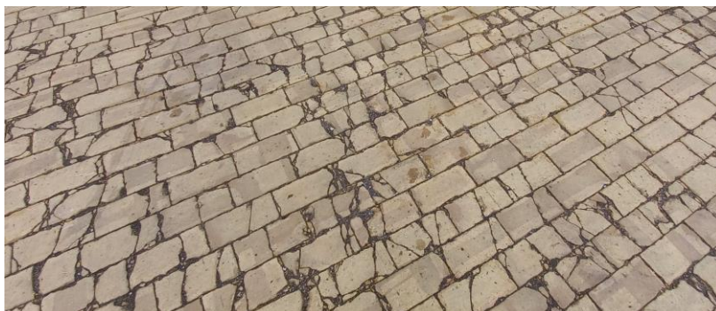
Teglstensbelægningen er ikke velegnet til tung trafik – stenene krakelerer.
